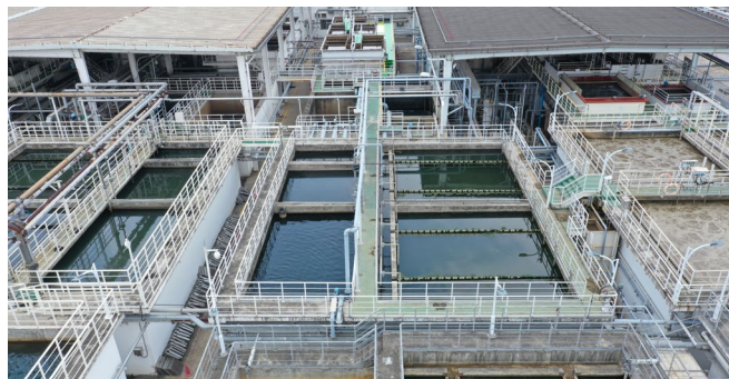
广汽丰田污水处理站
